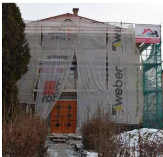
Obr. 1. Obnova fasády objektu Múzea Martina Benku. Foto M. Kiripolská, 2021.
